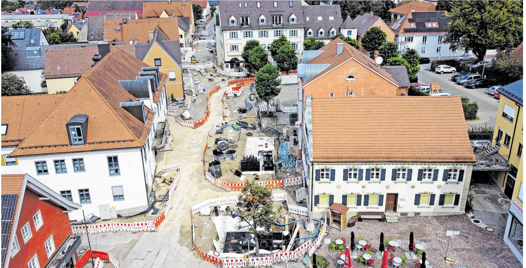
Wie weit die Baumaßnahmen in der Ortsmitte gediehen sind, wurde auf der Bürgerversammlung mittels Drohnenaufnahmen gezeigt.
